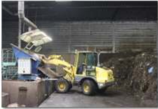
Figura 8.4 Pala cargadora descargando residuos en la unidad de alimentación
